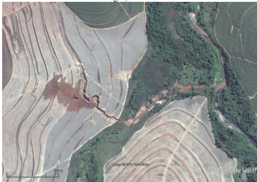
Figura 2: Rompimento das curvas de nível, surgimento da voçoroca e deposição do material erodido nos cursos d'água, em 2016.
